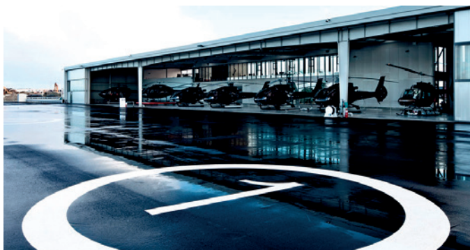
Pick Point Helipuerto - Auckland (Nueva Zelanda)
