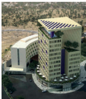
FORO 4 / EN EJECUCIÓN 2018, León Guanajuato
